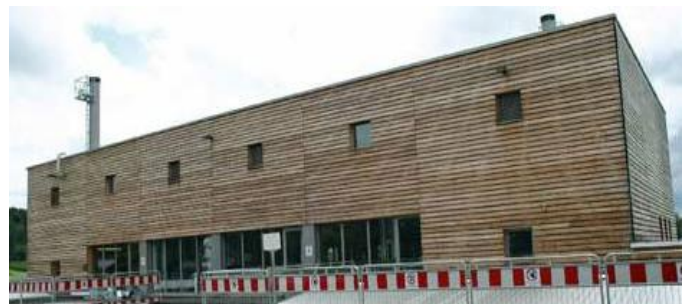
La nueva planta de generación de energía en Liebenau
